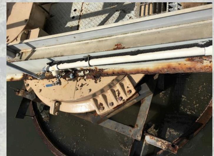
Clarificador existente (puente y mecanismo corroídos)
