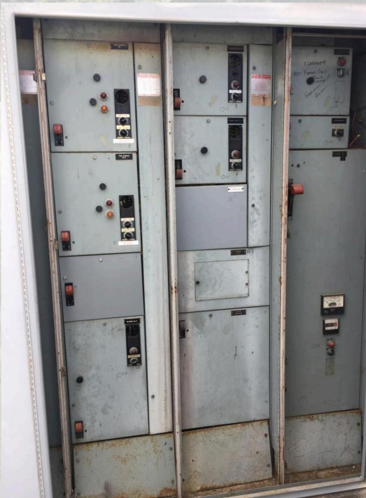
MCC existente (corroído, deteriorado e inseguro)
