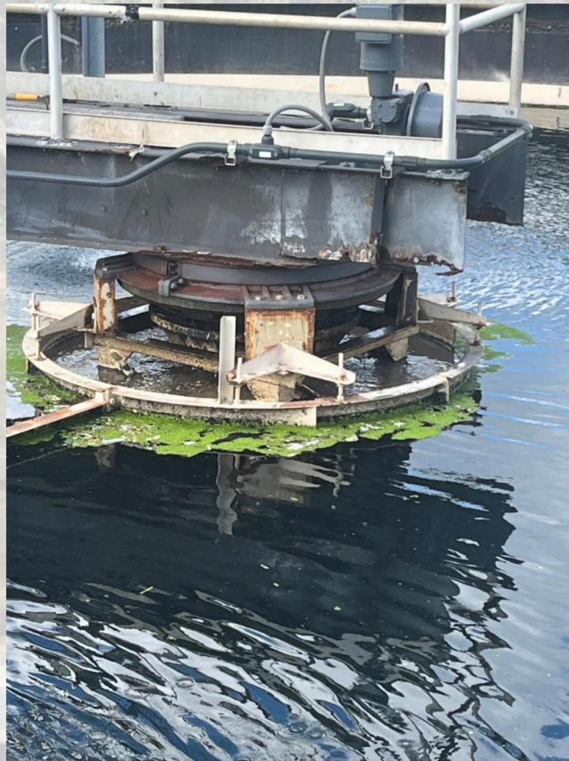
Clarificador existente (puente y mecanismo corroídos)
