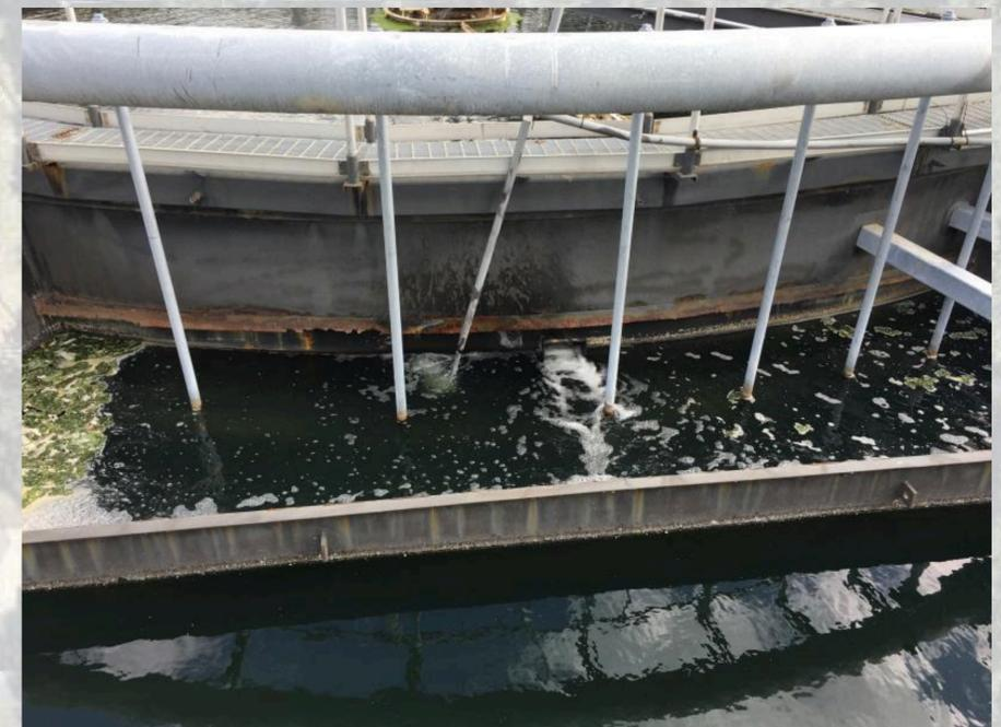
Pared interior de MPU de Bullseye existente (reforzadores corroídos)
